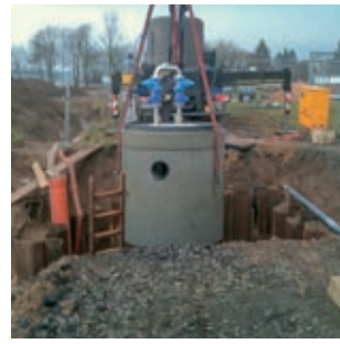
Pumpenschacht wird in Baugruppe versetzt
