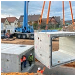
Rahmenelement auf Baustelle
