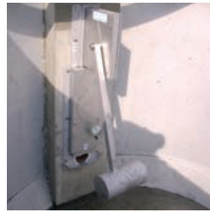
Schwimmergesteuerter Drosselschieber
