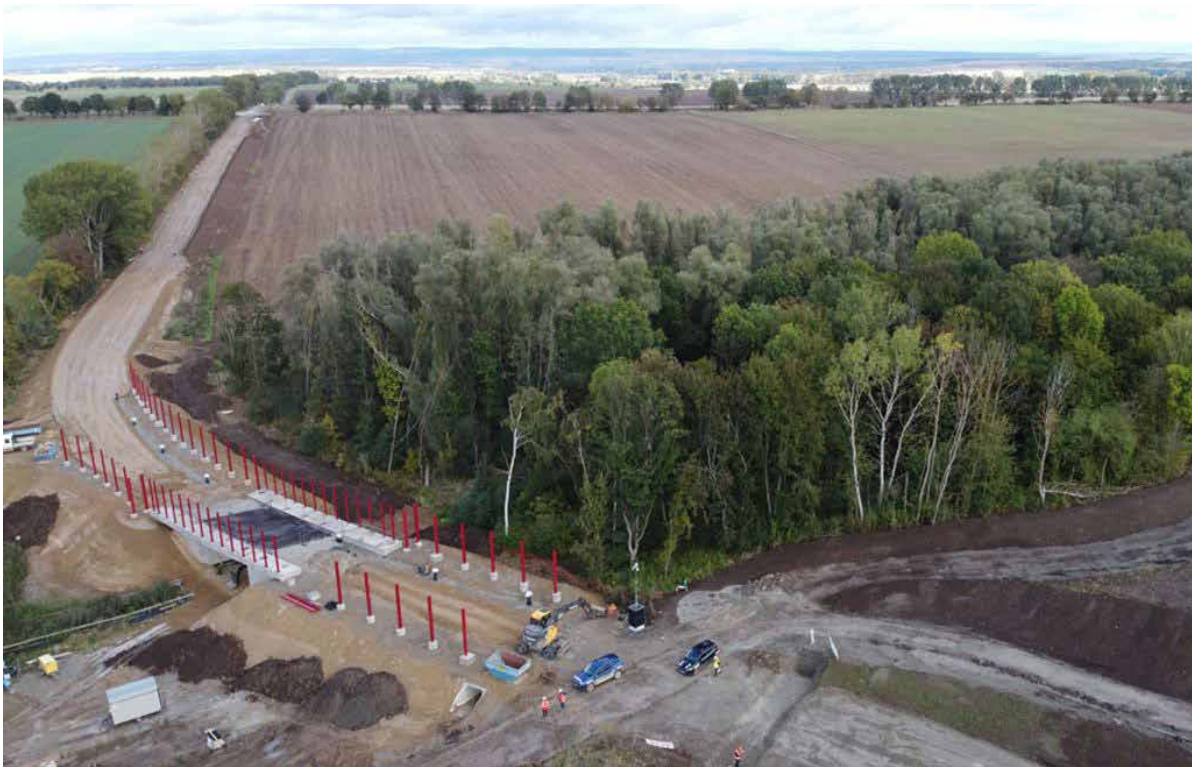
Neben Stahlbetonrohren und Schächten lieferten wir unter anderem auch einige Rahmendurchlässe mit Längen von 20 bis 75 Metern für den Amphibienschutz.
