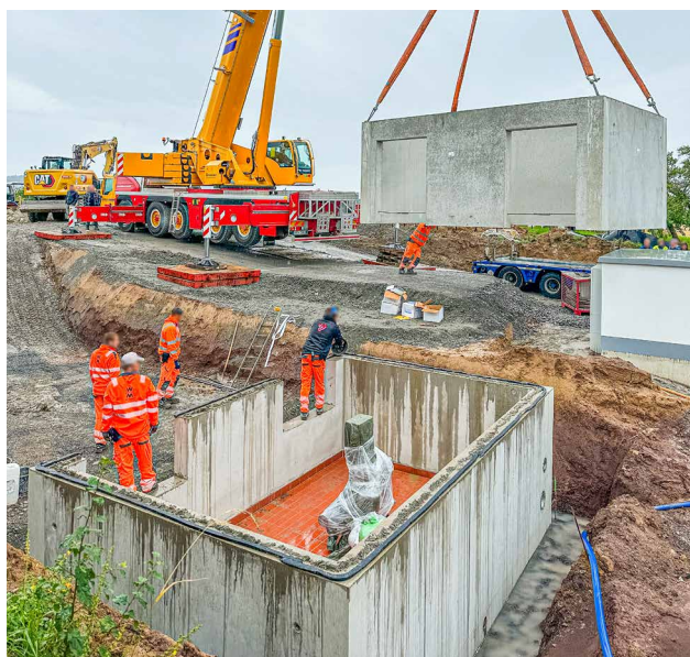
Im ersten Schritt wurden die Fertigteile versetzt, in denen die Pumpentechnik für die Druckerhöhungsanlage ihre Arbeit verrichtet.
