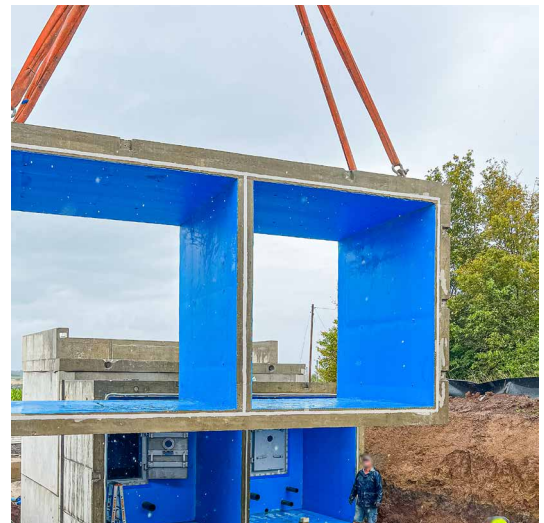
Die Elemente, aus denen sich der Trinkwasserspeicher zusammensetzt, sind perfekt aufeinander abgestimmt, um die Anlage mit der erforderlichen Dichtigkeit zu betreiben.
