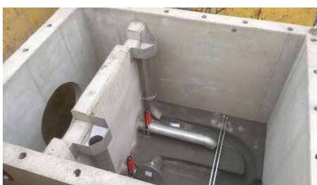
Ein Drosselbauwerk sorgt dafür, dass das im Rückhaltekanal angestaute Wasser nur verzögert in den Ablauf mit kleinerem Querschnitt abgegeben wird.
