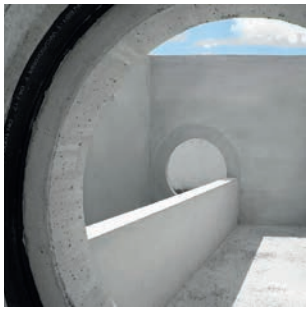
Bauwerk mit Schwellenwand
