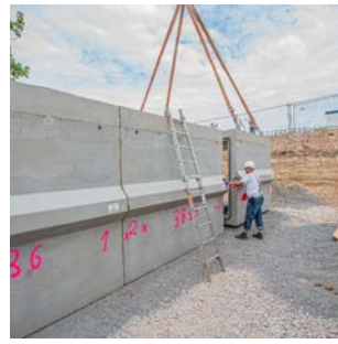
Rahmenelemente werden verbunden
