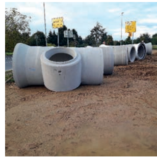
Stauraumkanäle auf Baustelle
