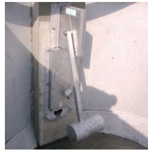
Schwimmergesteuerter Drosselschieber
