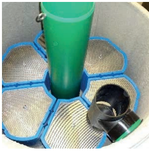
Filterkartuschen im Behälter
