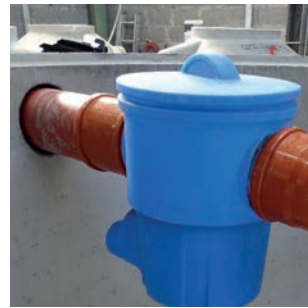
Filter im Behälter
