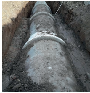
Eingebautes Speicherbauwerk
