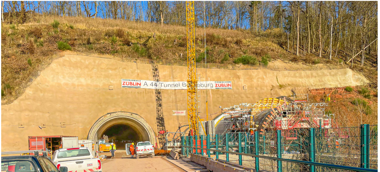
Die beiden Röhren am Südportal des Tunnels Boyneburg an der A44 bei Sontra.
