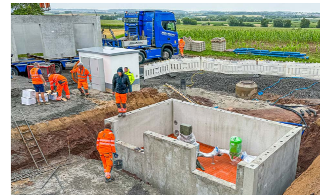
Die Montage der Betonfertigteile erfolgte an nur einem Tag.
