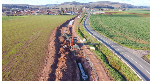
Der Regenwasserkanal wird aus dem Neubaugebiet entlang der Straße in ein Regenrückhaltebecken geführt.
