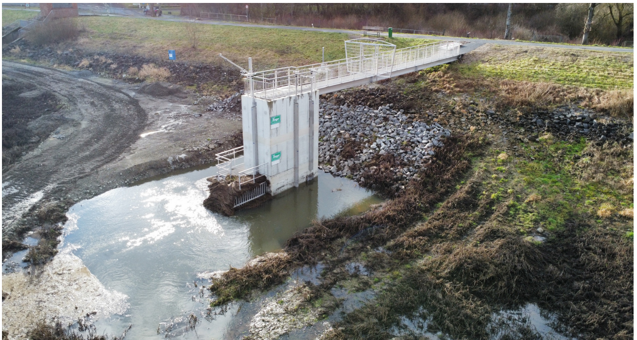
Vor dem Mönch-Zulauf wurde ein 3D-Rechenkorb montiert. Hierdurch soll ein Rückhalteschutz gegen Geschiebe und Treibgut gewährleistet werden.
