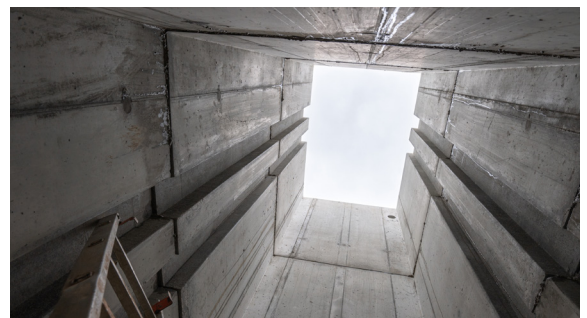
Die lichten Maße der vorderen Kammer betragen 2,15 m x 1,60 m und die der hinteren Kammer 1,00 m x 1,60 m. Nach oben hin ist das Mönchbauwerk komplett offen.
