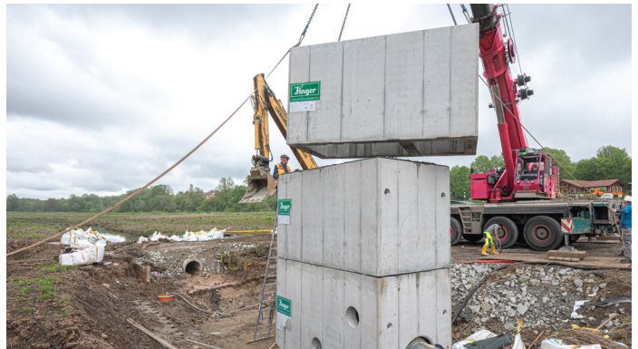
Der Aufbau des Mönchbauwerks erfolgte am 6. Mai 2024 auch dank der Fertigteilbauweise an nur einem Tag sehr reibungslos.
