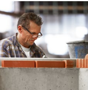
Bei Finger-Beton werden alle Schachtgerinne individuell in Handarbeit mit Klinkersteinen vollfugig gemauert.
