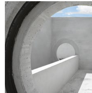
Bauwerk mit Schwellenwand eingebaut
